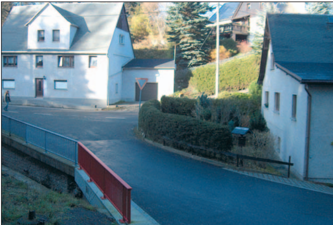
Neubau Straßenbrücke zum Freibad Krumhermersdorf
