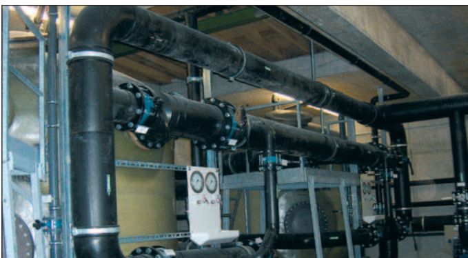
Neugestaltung Freibad Krumhermersdorf, Einbau Wasseraufbereitungsanlage
