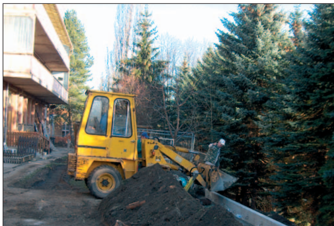
Beseitigung Sicherheitsmängel Hof und Freiflächen Kindereinrichtung „Pfiffikus“
