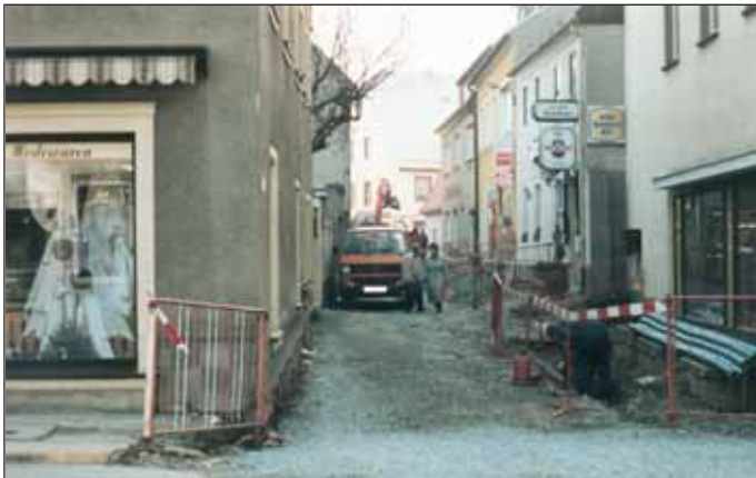
Die Körnerstraße während der Bauarbeiten
