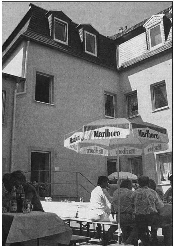
Wohn- und Geschäftshaus Altmarkt 6 erstrahlt nach zweijähriger Bauzeit im neuen Glanz
