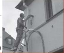
Die Einblasdämmung eignet sich besonders für nachträgliche Wärmedämmung und kann neben den bekannten sehr guten Wärmedämmeigenschaften auch auf einen hervorragenden sommerlichen Wärmeschutz verweisen. Zudem trägt sie erheblich zur Verminderung der Lärmbelastung bei. Realisierungszeiten von 1-2 Tagen halten die Belastung in geringem Umfang und die Kosten niedrig (15-30 €/m<sup>2</sup>). Die Verfahren und Materialien sind vom Institut für Bauphysik zertifiziert.
