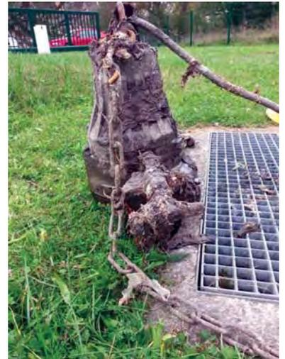
Dieses Bild zeigt die Verstopfung einer Pumpe im Pumpwerk Gerbergasse in Zschopau.
