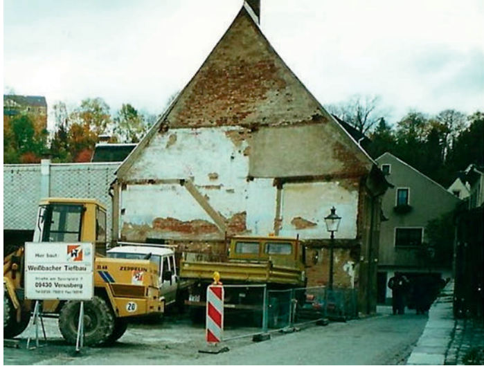
Untere Mühlstr. 11 während Straßensanierung 2000
