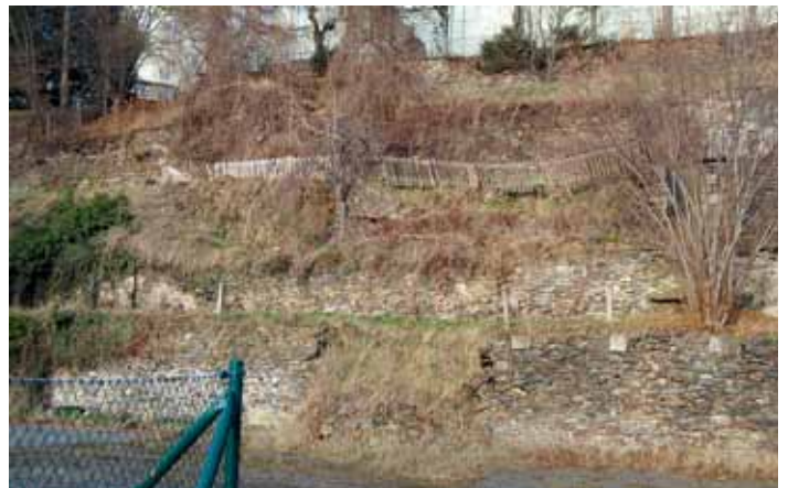
Aktueller Zustand des Seminargartens (Aufnahme von 2016)
