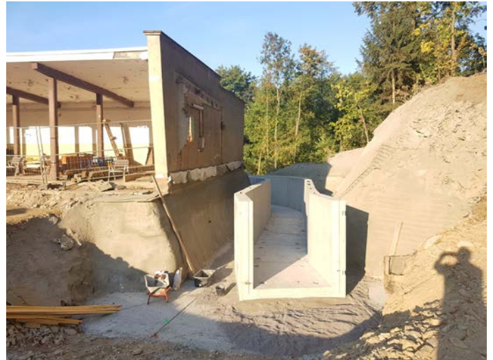
Felsdurchbruch, Gebäudesicherung und Einbau des Durchlasses im Bereich der Kegelbahn
