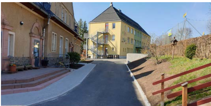
Nach den Baumaßnahmen
