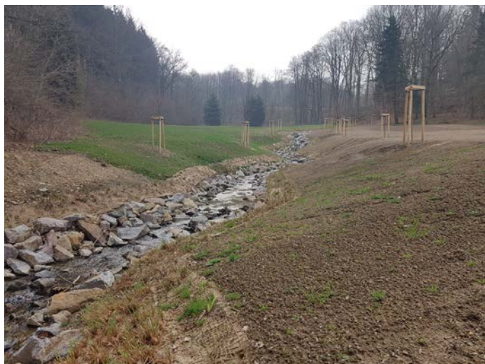
Neu entstandener offener Gewässerabschnitt im naturnahen Ausbau
