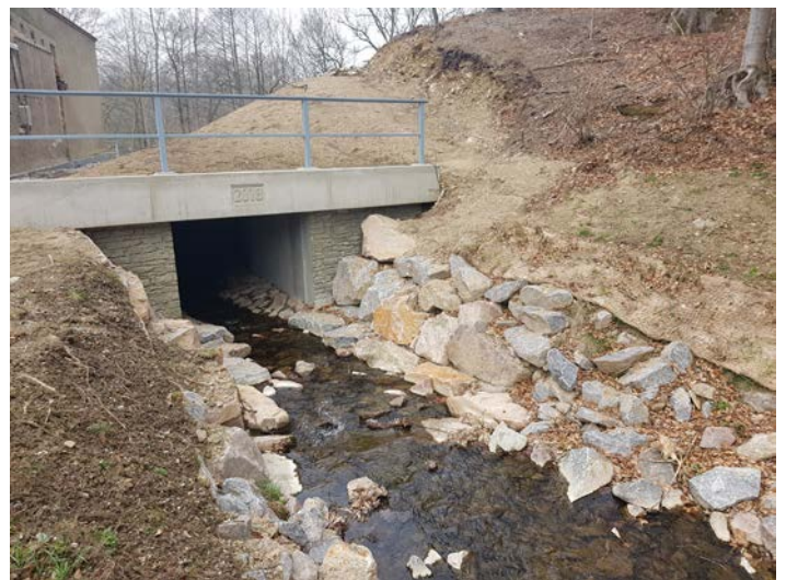
Fertig gestellter Durchlass
