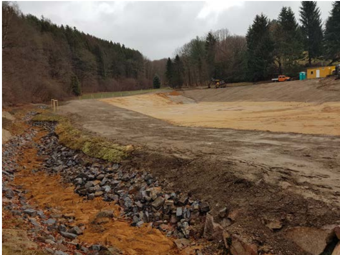
Naturnah gestalteter Bachlauf am nördlichen Rand des Tales kurz vor der Fertigstellung
