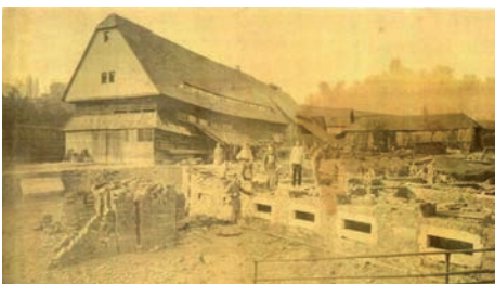
Bauphase Gabelsbergerstraße 2 im Jahr 1875 erkennbar sind Kellermauerwerk und Sockelbereich | markant die damals noch vorhandene Ziegelscheune (heute Waldkirchner Weg 1 gegenüber)
