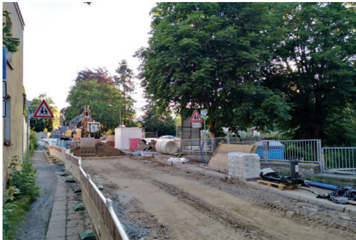
Bautrasse des 1. Teilabschnittes 2019, Kanalneubau Gartenstraße, Zschopau
