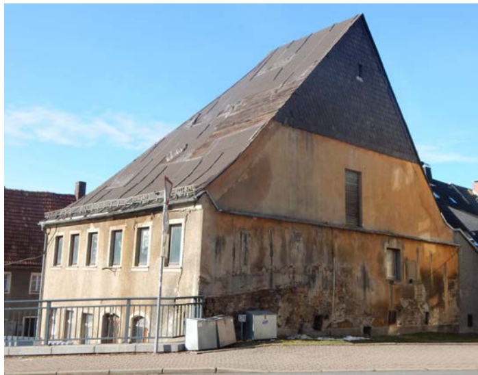
Aktuelle Ansicht der Chemnitzer Straße 47 (GSL Sachsen/Thüringen).
