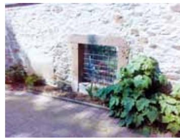
Reinigung von alten Putzresten sind diese beiden parallelen Mauern professionell mit einem Pinselputzverfahren vor Verwitterung geschützt.
