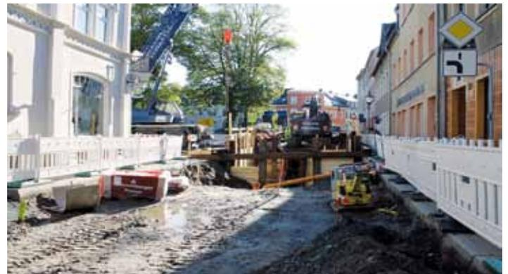
Vom S10 wurden für den Anschluss an den Mischwasserkanal An den Anlagen ca. 30 m im DN 600 Stahlbeton mit PE-Liner verlegt und ein weiteres Schachtbauwerk (S11) geschaffen. Für die Sanierung des Altkanals, die im August 2020 beginnen soll, wurde in Höhe Rudolf-Breitscheid-Straße 20 ein Zugang errichtet.
