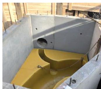
Schachtbauwerk S9 mit Auskleidung des Sohlgerinnes Kunststoff PP Seitenzuläufe DN 400/DN 1000
