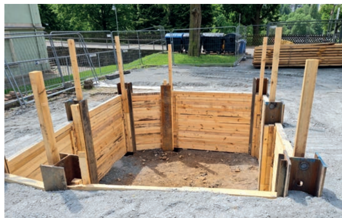
Trägerbohlwand als „Berliner Verbau“ im Gymnasiumgelände
