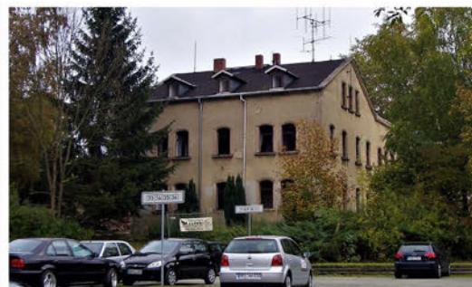
Baumeister Wendler-Villa bzw. Lehrerwohnhaus kurz vor dem Abriss 2007 Carsten Beier / Zschopau
