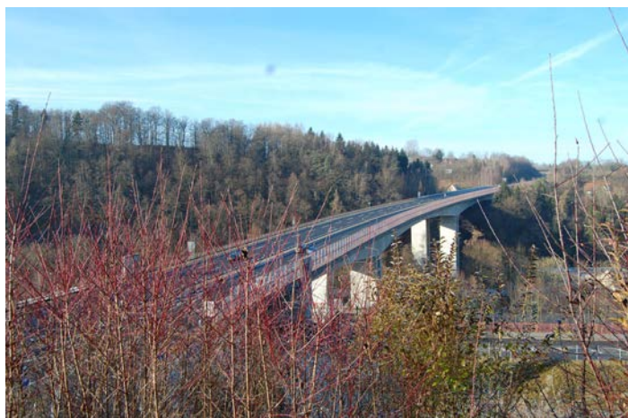
Talbrücke Zschopau der B174
