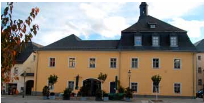
aktuelle Ansicht vom Neumarkt aus (Nordseite)
