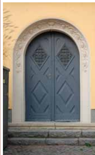
aktuelle Ansicht vom Altmarkt aus (Südseite) – ehemaliger Ratskellereingang von 1920
