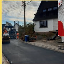
Ausbau- und Asphaltarbeiten am Akazienweg
