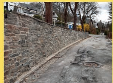
Sanierung Stützmauer am Birkenweg
