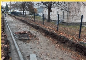
Sanierung des Fußweges an der Philipp-Müller-Straße
