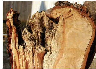
Oben: Pilze dringen in die Kappstelle ein und zerstören das Holz
