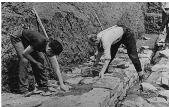
Ausmauerung der späteren Becken 1955 [Quelle: W. Ihle]
