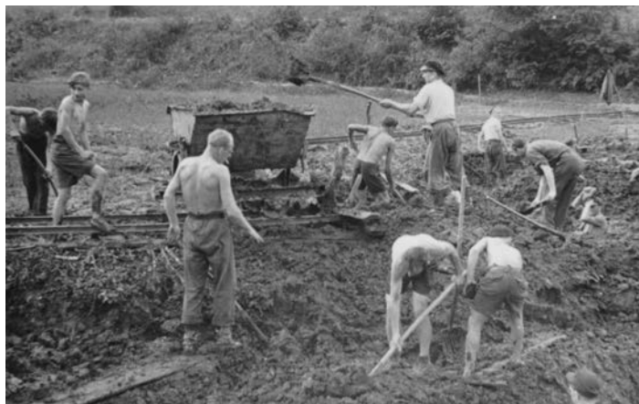
Aushub des späteren Schwimmerbeckens 1953 [Quelle: W. Ihle]
