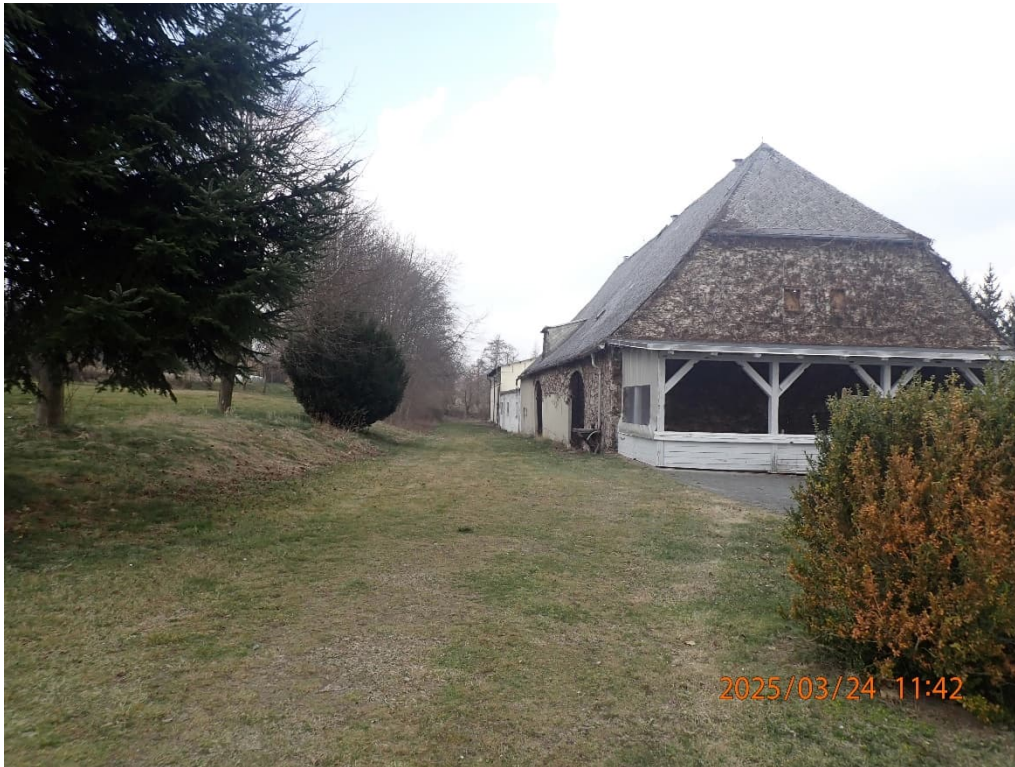
Abbildung 8: Aufnahme Kulturdenkmal 08961764 „Rotes Vorwerk“ 19
